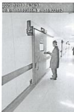
附图三 现场检测照片
