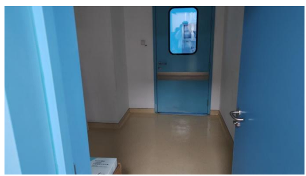
辅料室现状 (DSA 室东侧)
