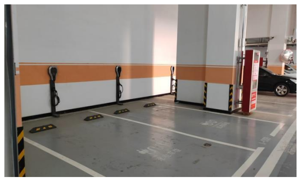
地下停车场现状 (DSA 室下方)
