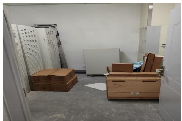
设备间现状 (DSA 室西侧)
