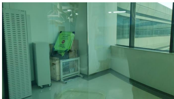
DSA/CT 设备间现状 (01 手术间南侧)
