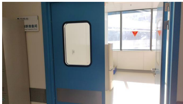
麻醉准备间现状 (01 手术间下方)
